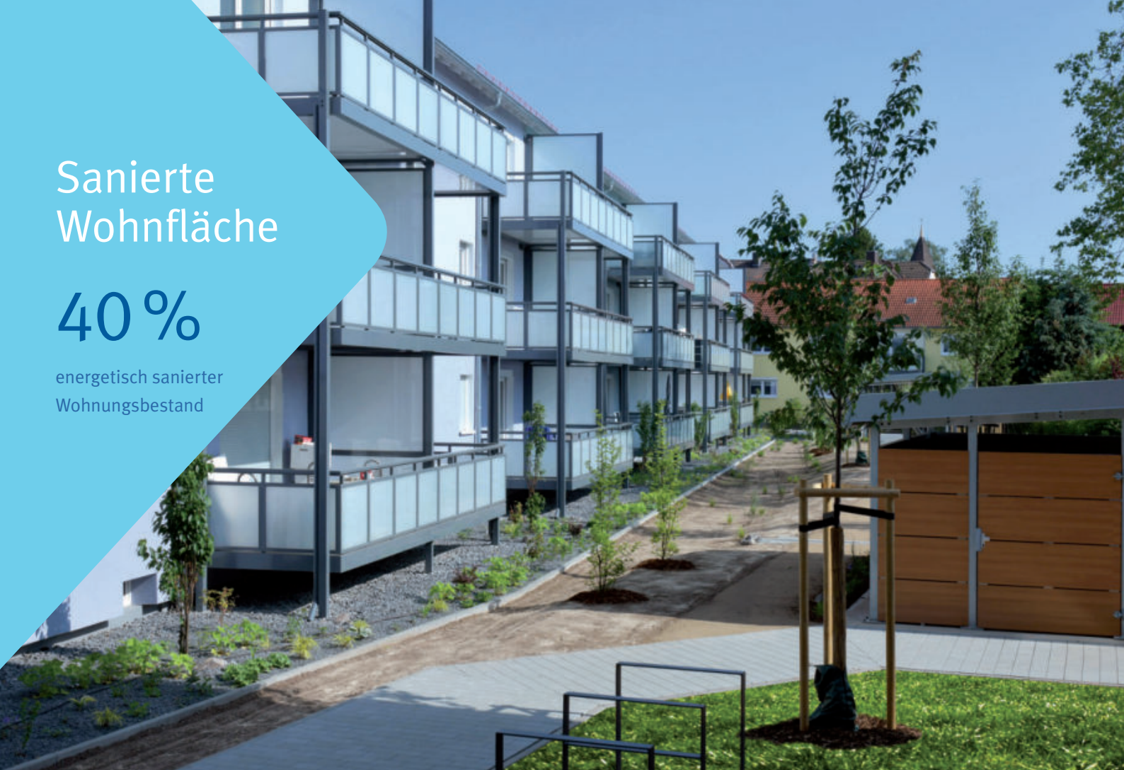
Laurentiusstraße – vollumfassende Modernisierung
