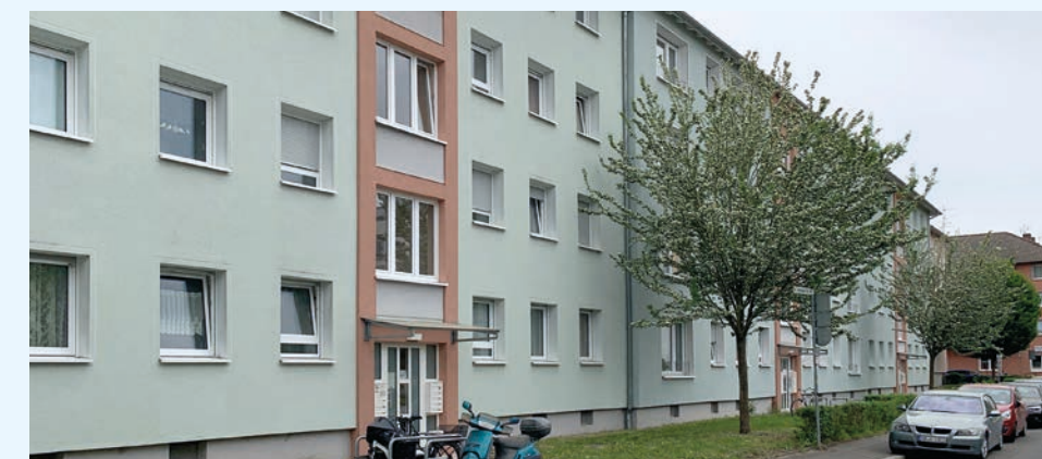
Fenstertausch, Breslauer Straße 30-34
