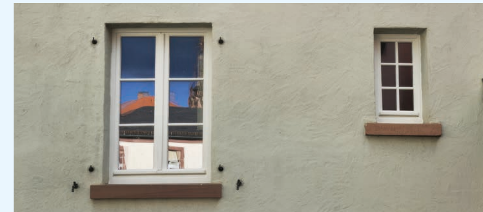
Fenstertausch, denkmalgerechte Instandsetzung, Stiftsgasse 10a
