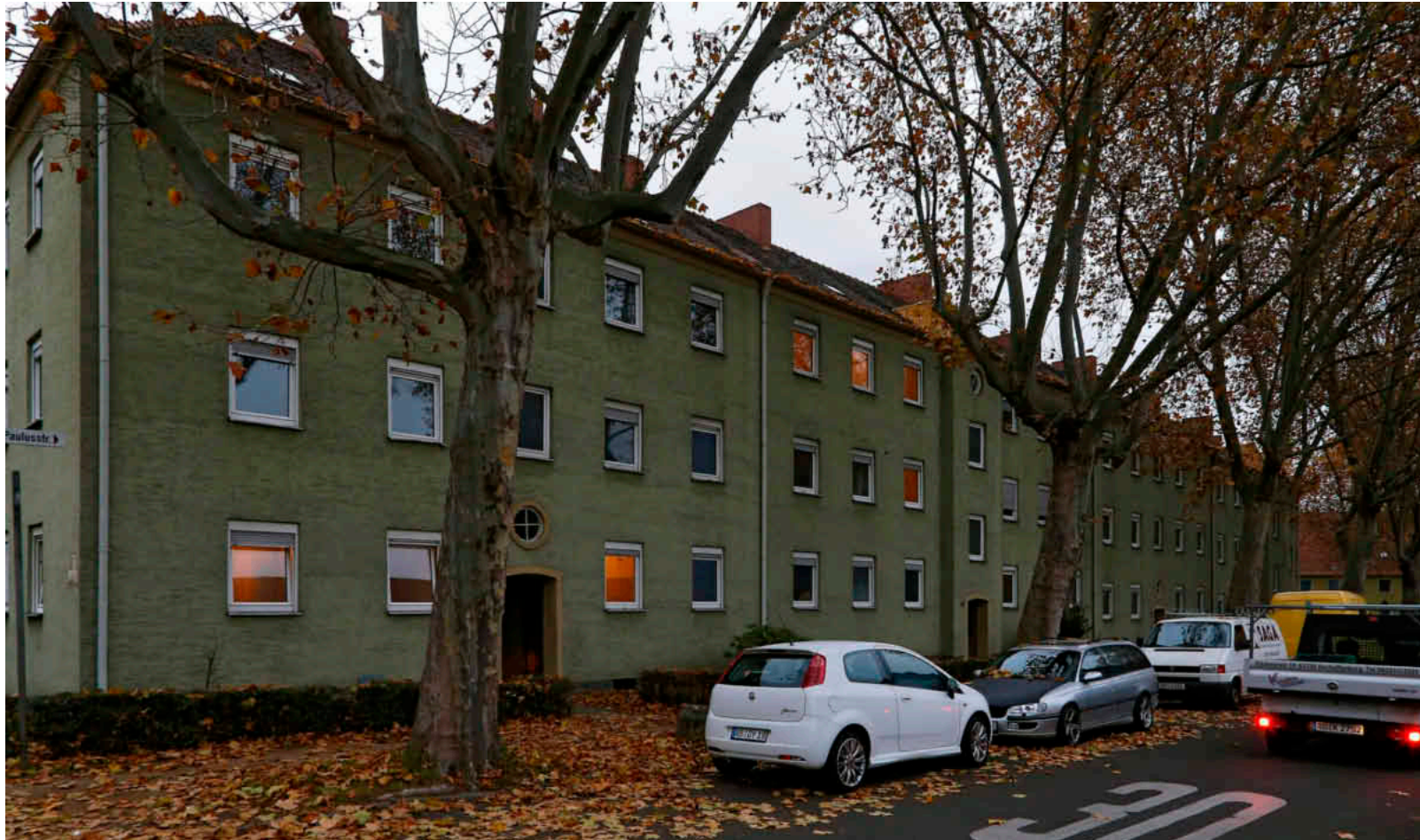
Abriss verschoben: In den Stadtbau-Wohnblock an der Dämmer Paulusstraße 21 bis 29 sollen vorübergehend Flüchtlingsfamilien einziehen. Handwerker bereiten die weitgehend leerstehenden Häuser für die neuen Bewohner vor. Die Nachbarschaft wird am 22. November in einer Versammlung über die Pläne der Stadt informiert. Foto: Stefan Gregor
