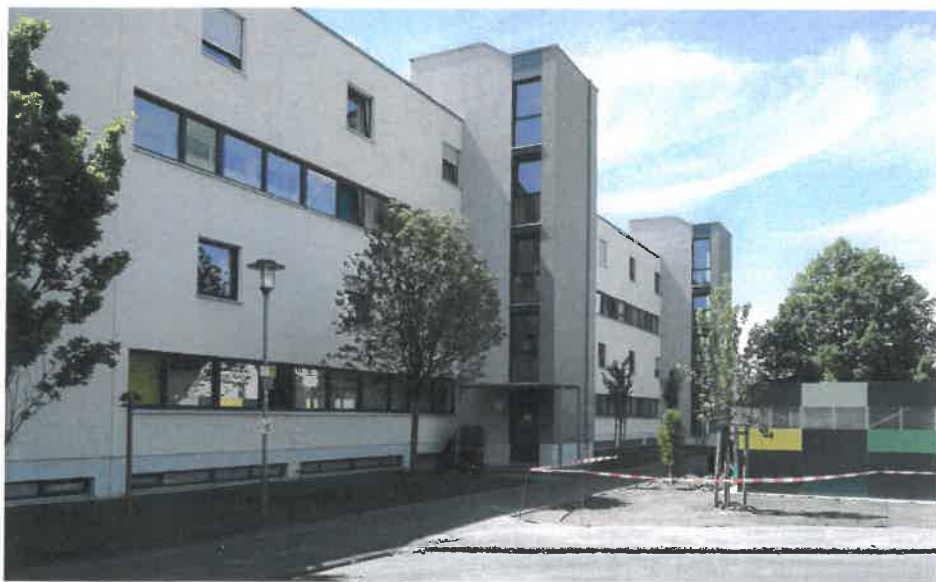
Oben: Sanierter Bauabschnitt und Gebäudebestand der Wohnlage in Aschaffenburg.
